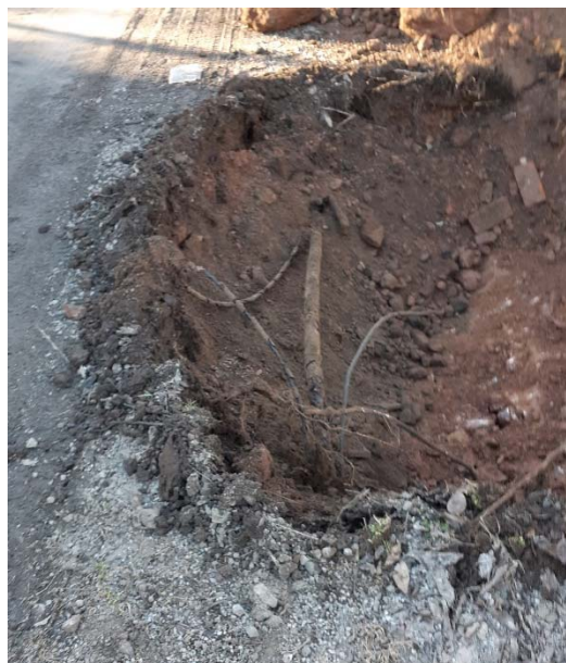
Figur 18. PG3, avgrävda kablar.
